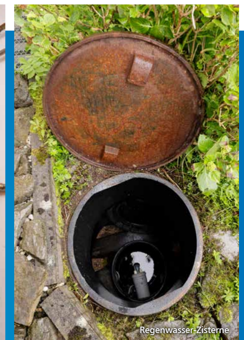
Regenwassernutzungsanlage
